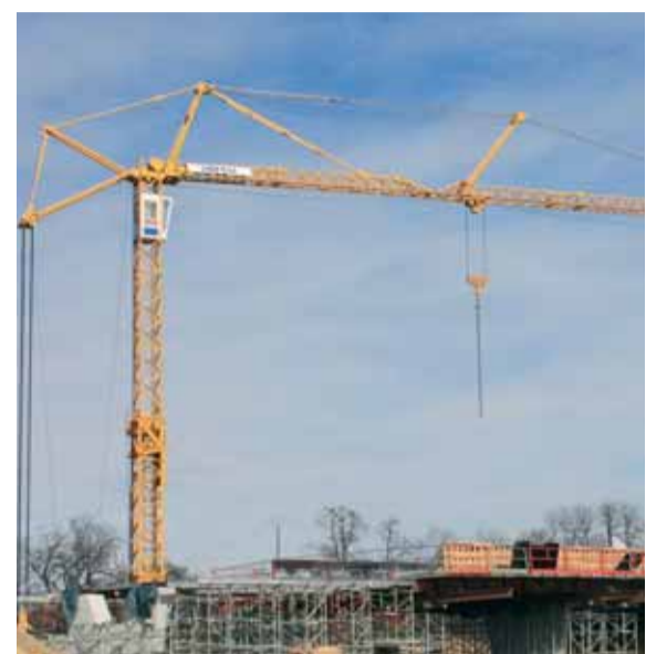
Chantier de la RN 59
